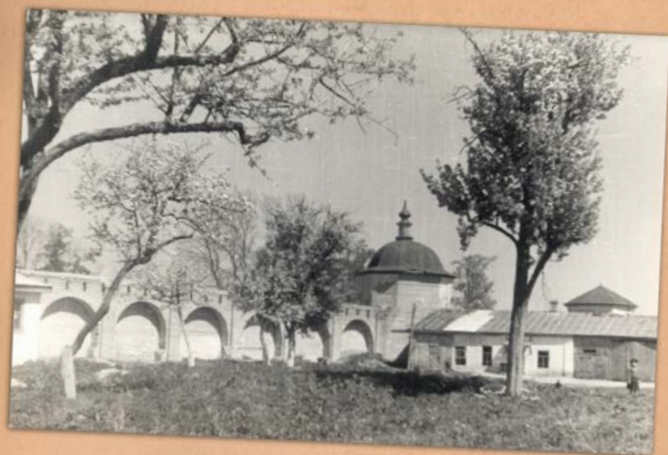
СТЕНА И БАШНЯ МОНАСТЫРЯ. 1735-1764гг. ВИД С ТЕРРИТОРИИ МОНАСТЫРЯ. (ФОТО АВТОРА 1949 Г.)
